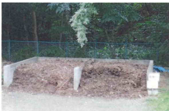
落葉の堆肥化ヤード
