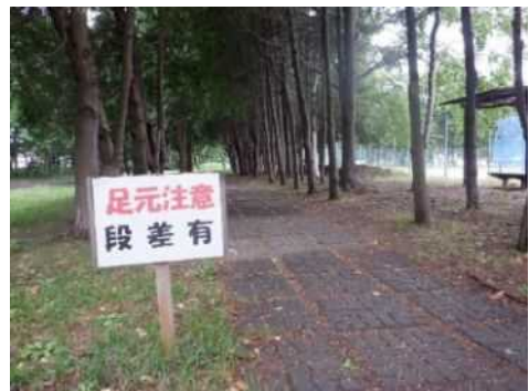
園路の修繕箇所
