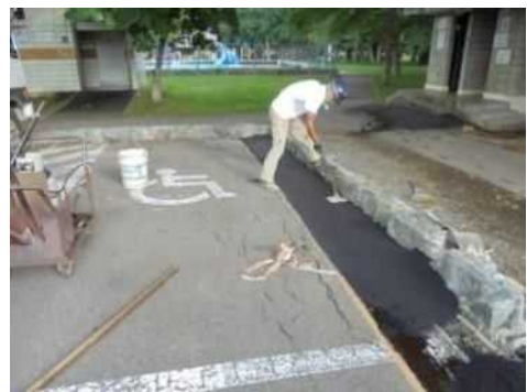
園路に出ている根の処理
