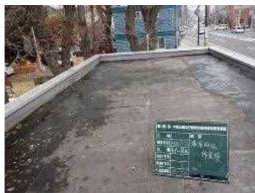
トイレ屋上 落葉清掃後
