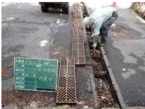
U型側溝清掃中
