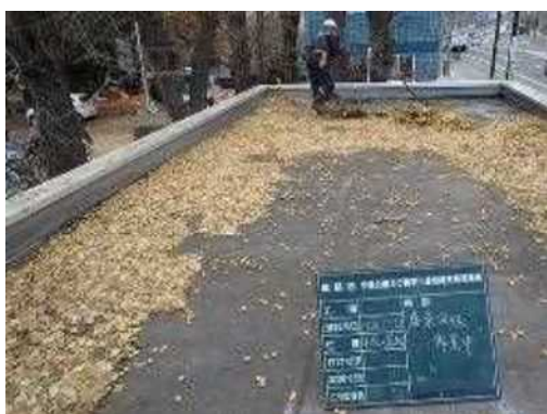
トイレ屋上 落葉清掃中
