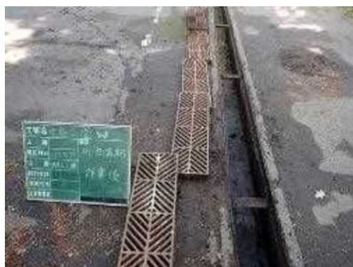
U型側溝清掃後
