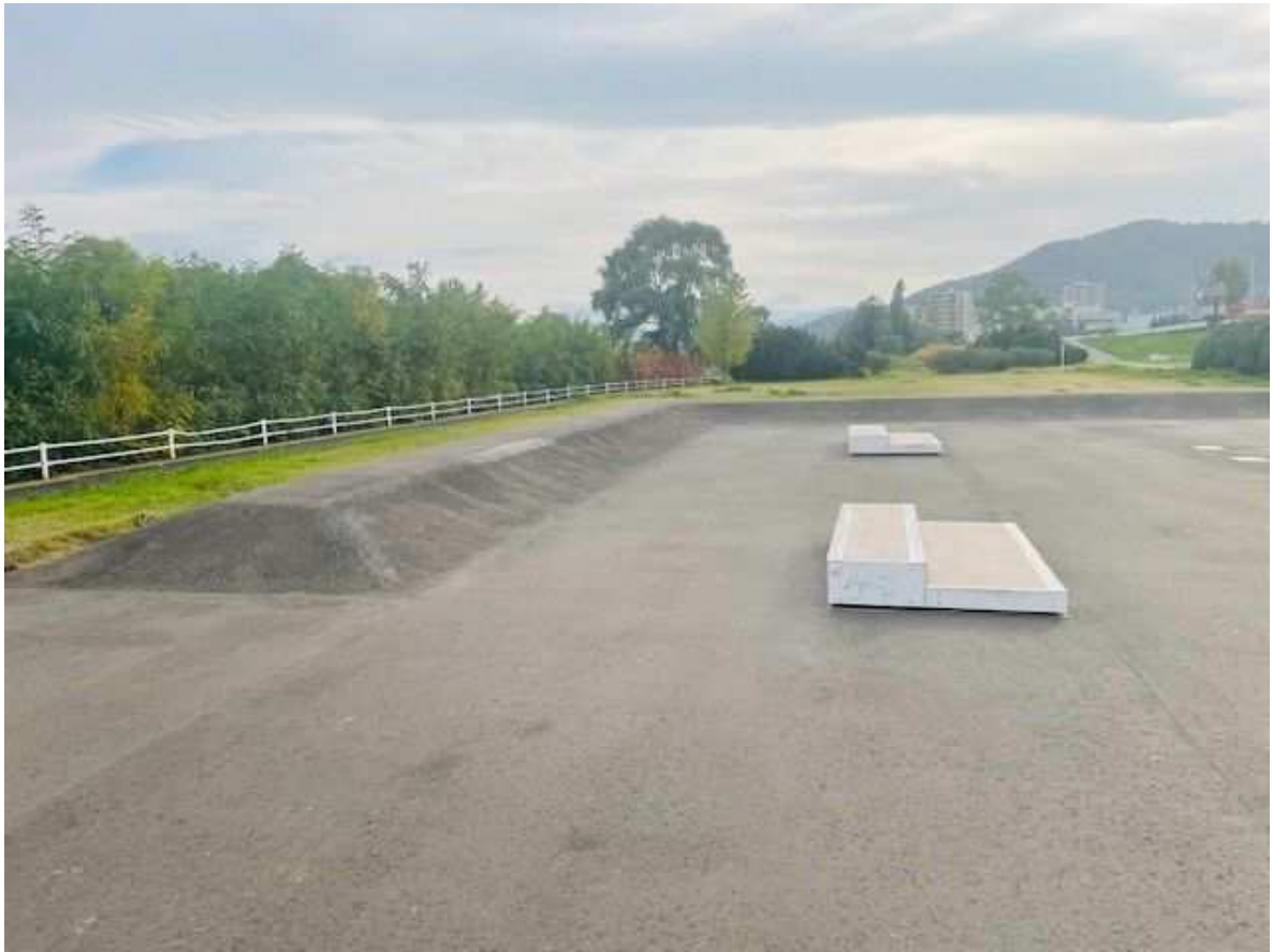
参考：令和6年度仮設スケボーエリア セクション設置写真
