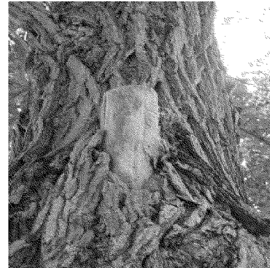
【西側】上部剪定痕からの腐朽
