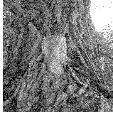
【西側】上部剪定痕からの腐朽
