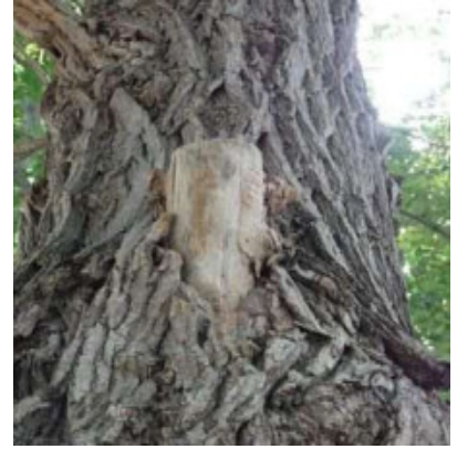
【西側】上部剪定痕からの腐朽
