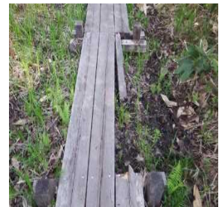
破損した木道(自然歩道)
