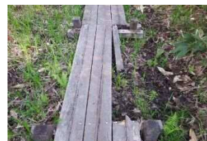
破損した木道（自然歩道）
