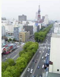
創成川公園整備前
