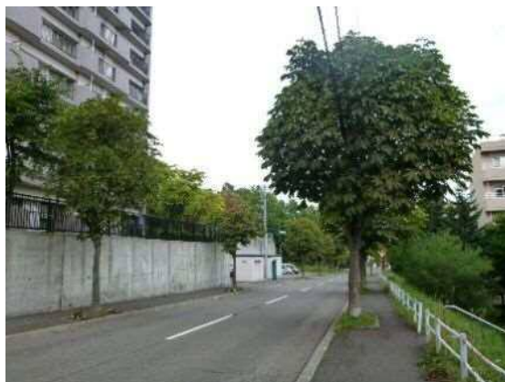
幅が狭い歩道の街路樹
