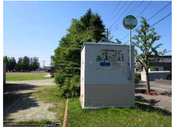
公園に設置された緊急貯水槽
