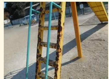
さびや損傷等、遊具の劣化が発生
