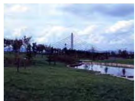
堤防の住宅地側を緑化した例
