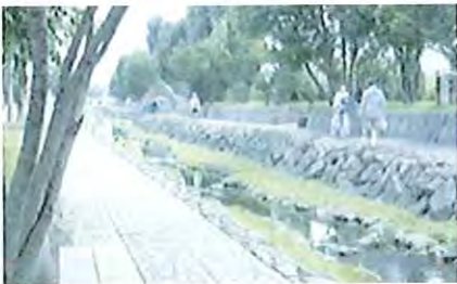
<安春川：散策路の整備>
