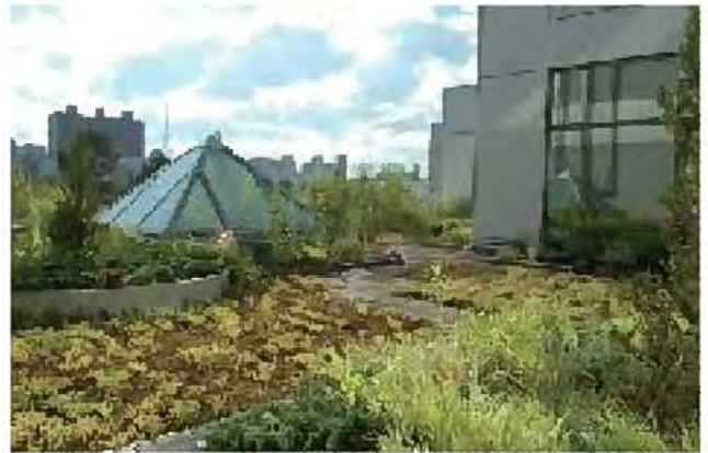
厚別区役所の屋上緑化
