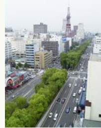
創成川公園整備前
