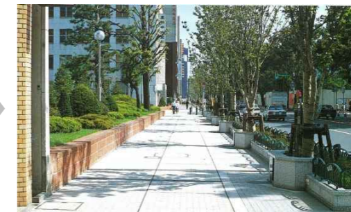
整備後(平成元年9月撮影)
