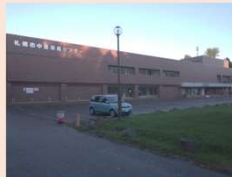
▲中島体育センター外観
