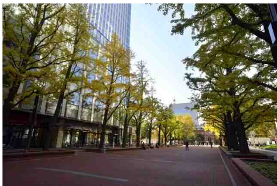
札幌三井 JP ビル（平成 26 年 8 月竣工）
