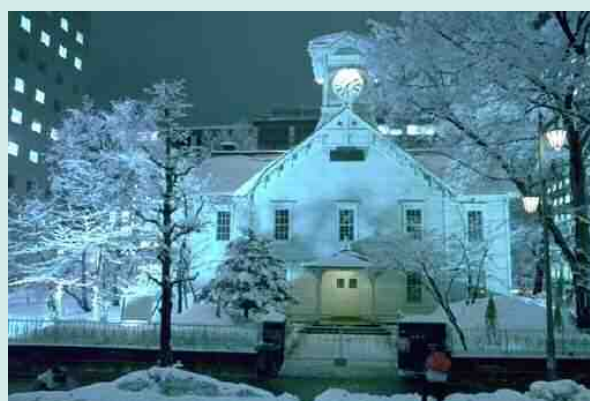
樹木や建物に雪が積もり積雪寒冷地ならではの景色が創出されている（時計台）
