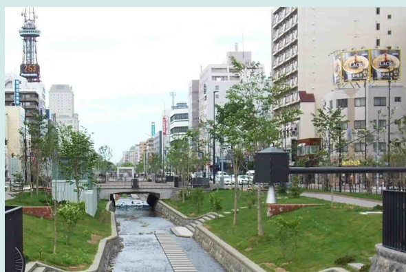
都心における貴重な水辺とみどりを活かし、みどり豊かで象徴的な親水空間や四季を通じたうまいある空間を形成（創成川公園）
