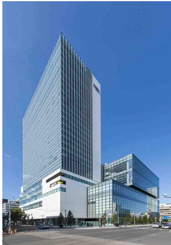
札幌創世 1.1.1 区北 1 西 1 地区（平成 30 年 5 月竣工）
