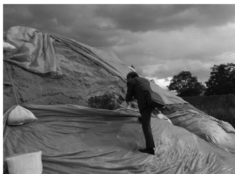
建設残土の管理状況調査
