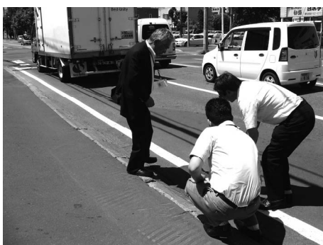
道路の陥没に関する調査
