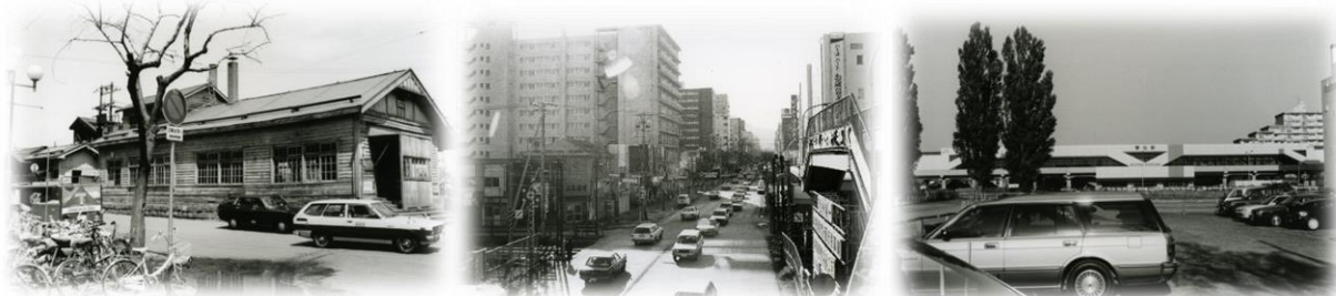
(写真左) 国鉄琴似駅駅舎 (S54)、(写真中央) 高架化前の琴似駅踏切/区役所撮影
