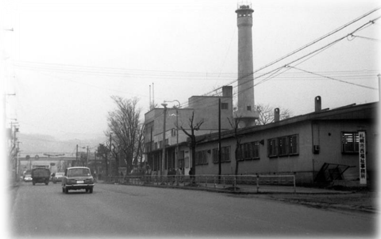
西区役所開設前の琴似本通（S40年代）/吉川氏提供 ※現在の区役所建設地には、札幌市西福祉事務所が設置されていた。
