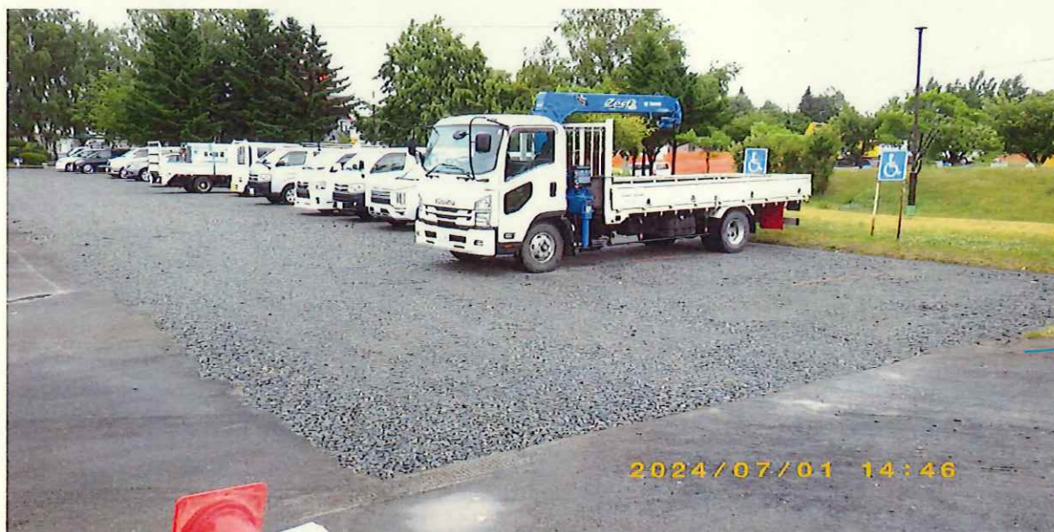
入口側 ※碎石舗装 施工済 ※ラインテープ 未施工
