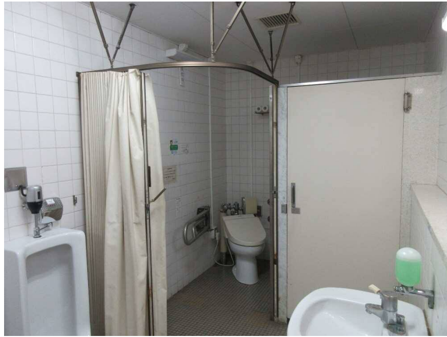
【西区役所 1階男性用トイレ現況写真】
