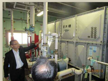
受水槽の確認
