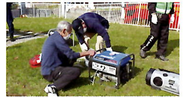
発電機を起動させてみる
