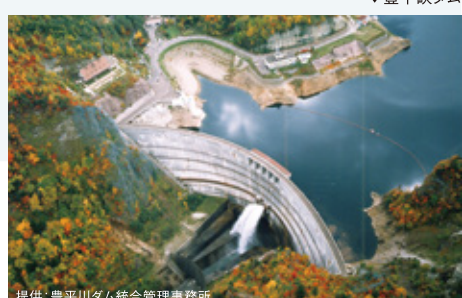
提供:豊平川ダム統合管理事務所
