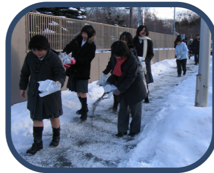
ツルツル路面への砂まき
