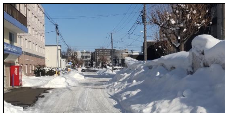
③水車通6号線（緑矢印に向かって撮影） 概ね除雪されていたが、一部、建物の前に他の場所より高い雪山ができて（写真右側）、道路幅も狭くなっていた。
