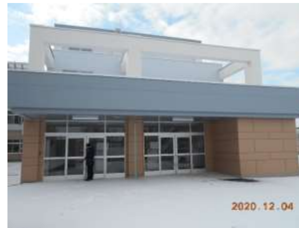
② 外観昇降口
