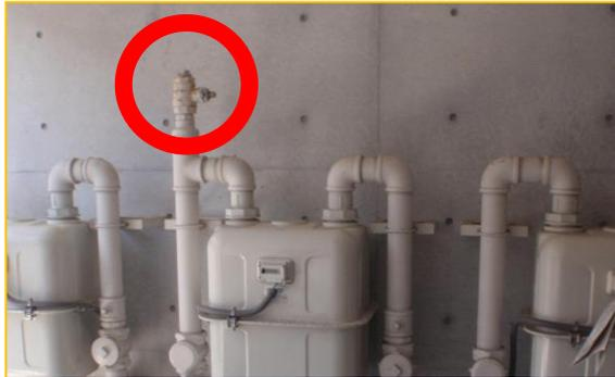
ガス変換機接続口
