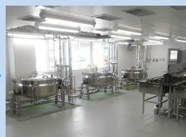
ドライシステムの給食調理室
