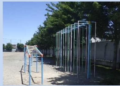
塗装が剥離し老朽化した遊具
