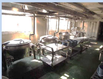
老朽化した給食調理室
