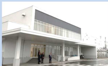
福岡市第3給食センター外観
