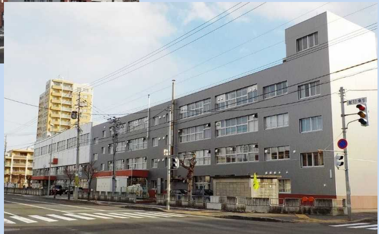
リニューアル改修事例（美香保中学校）
