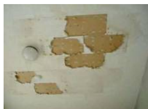
築 41 年 漏水による天井材劣化
