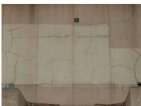
築 30 年 外壁ひび割れが発生
