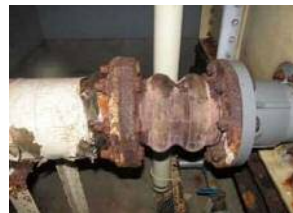
築 32 年 給水設備の老朽化
