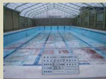
築16年 プール槽の塗装の劣化
