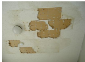
築 41 年 漏水による天井材劣化
