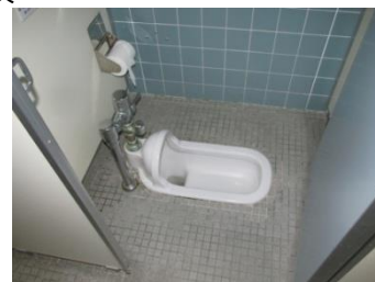
床がタイル敷きの和式便器
