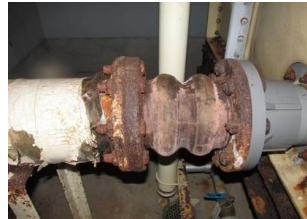
築 32 年 給水設備の老朽化
