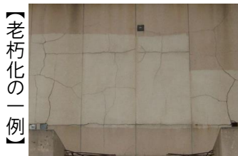
築 30 年 外壁ひび割れが発生
