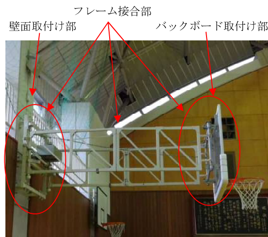
写真付 1.2.2：壁面式バスケットゴールの主な確認ポイント
