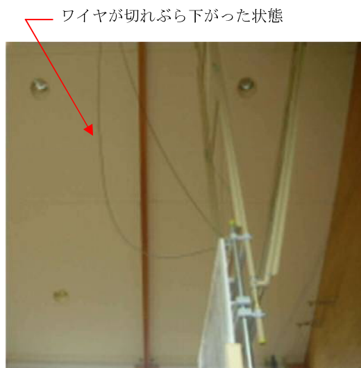
写真付 1.2.7 : ワイヤの劣化・損傷例 18)
