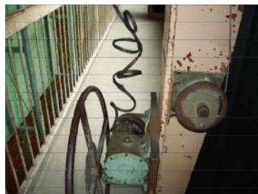
写真付 1.2.7 : ワイヤの劣化・損傷例 18)
