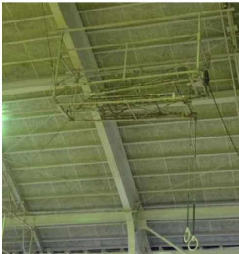
写真付 1.2.5 : 天井に設置された体操用のつり輪 (吊下式バスケットゴールに類似する運動具) の例
