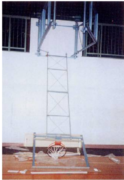
写真付 1.2.4 : フレーム接合部が外れて落下したバスケットゴールの例
