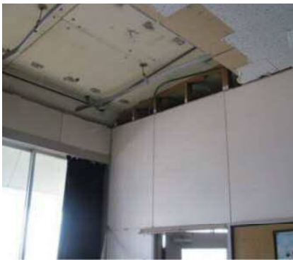
写真 1. 壁際の破損
