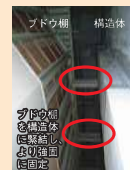
写真3. ブドウ棚天井と構造体の繋ぎ (下からの見上げ)
