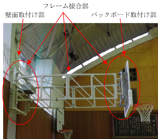
写真付 1.2.2 : 壁面式バスケットゴールの主な確認ポイント
