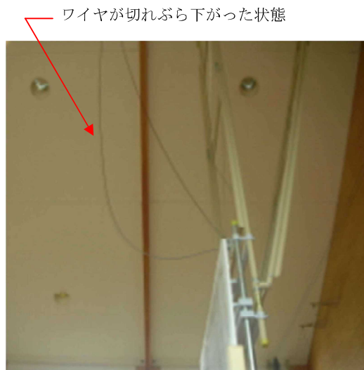
写真付 1.2.7 : ワイヤの劣化・損傷例 18)
