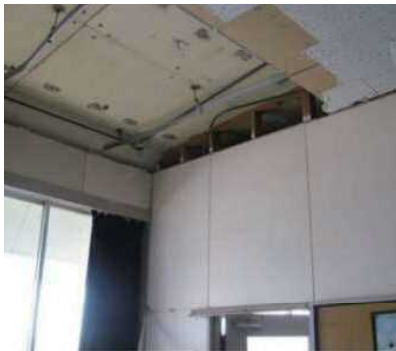
写真 1. 壁際の破損
