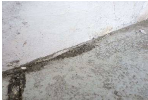
本体取付部：コーキング、ボルトの劣化
