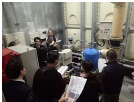
受水槽を確認している様子
