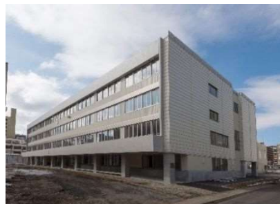
二条小学校の外観
