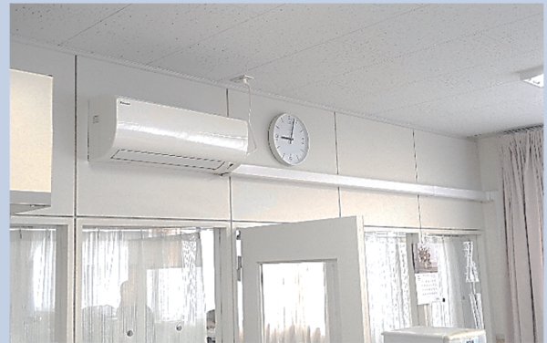
冷房設備（壁掛けエアコン）
