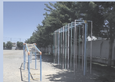
塗装が剥離し老朽化した遊具
