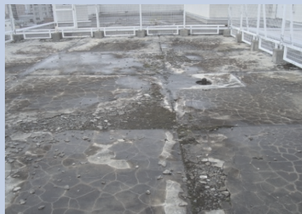
屋上保護コンクリートの劣化
