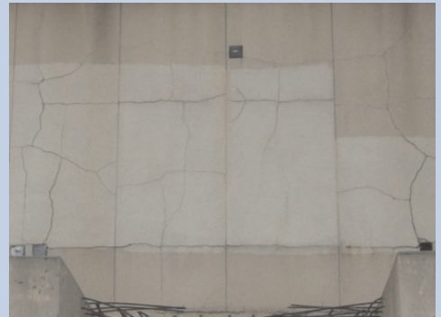
外壁のひび割れ、剥離
