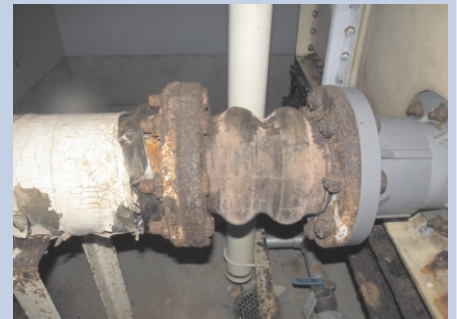
給水設備の老朽化
