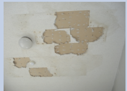
漏水による天井材の劣化
