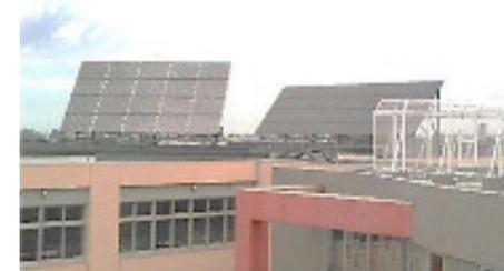
屋上に設置された太陽光発電システムから供給された電力は、校舎の配電線に送られて校舎内で利用しています。
