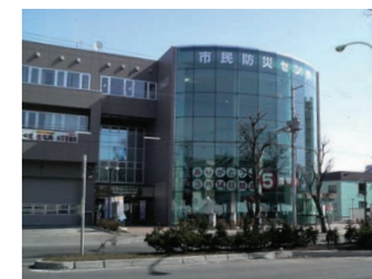
市民防災センター
