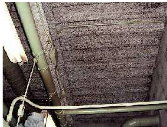
アスベスト含有吹付けロックウール(梁)
