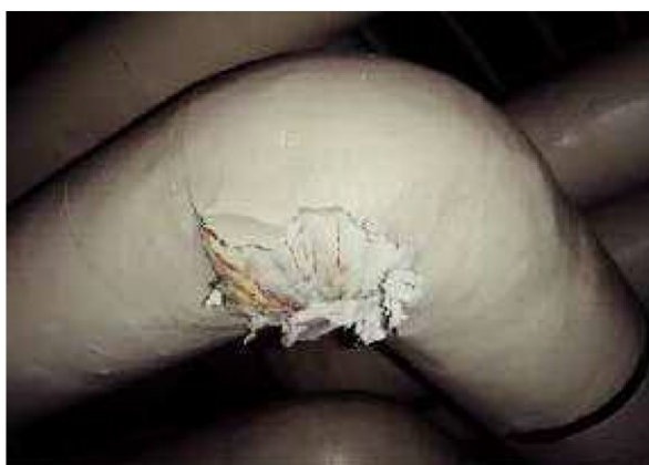
アスベスト含有配管保温材(配管)
