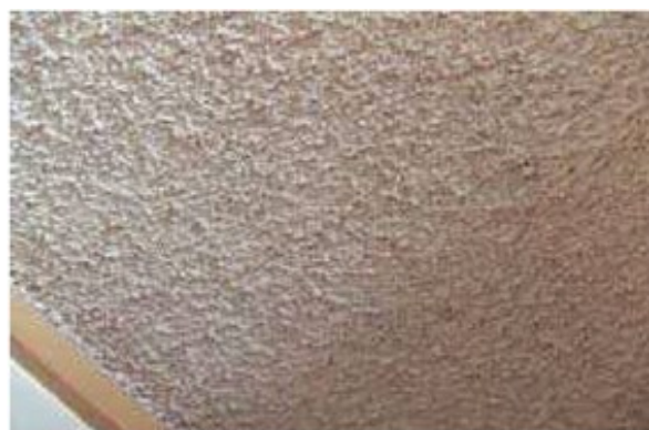
アスベスト含有吹付け バーミキュライト(天井)
