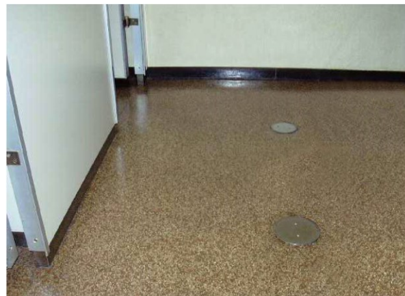
アスベスト含有ビニル床シート(床)
