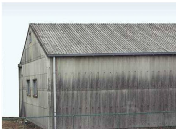
アスベスト含有スレート波板(屋根)
