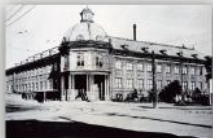
札幌鉄道駅構内
